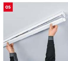
Fermez le luminaire en refixant le diffuseur sur le corps
