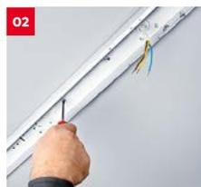
Faites passer le câble d'alimentation par l'entrée de câble, fixez le corps du luminaire sur la surface de montage
