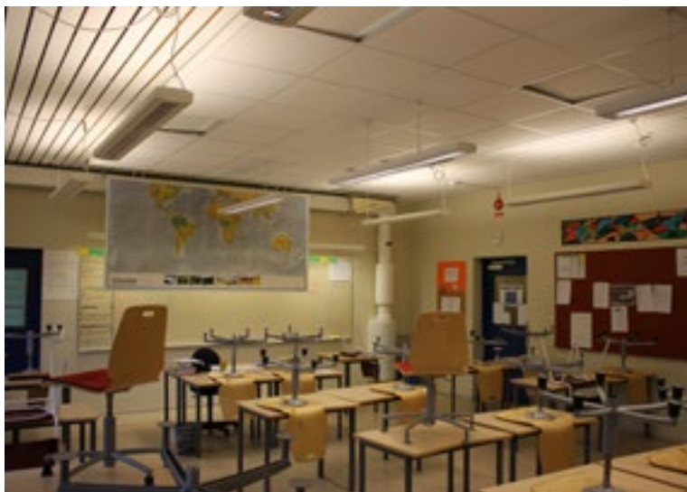
Den gamle installasjonen med eldre T5-armaturer.
